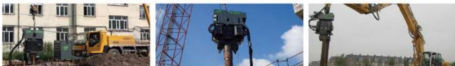
**演示目标：**证实可以振沉60米长钢管桩 / 无土壤置换 / 拔桩不带土
